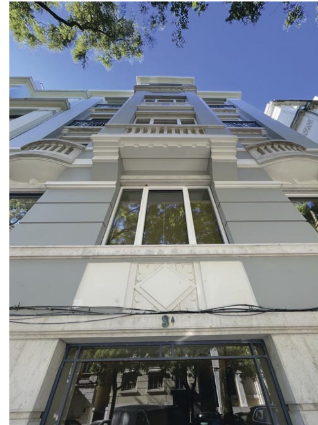
Réhabilitation du Bâtiment Art Déco, Lisbonne, Cristina Mantas
