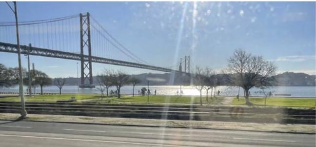
Vue du pont le 25 avril sur le Tage
