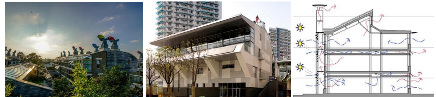
18. cité jardin au sud de Londres 19. pavillon anglais de l'exposition internationale de Shanghai en 2010 20. Le BRE : la coupe sur le plancher creux et les 5 cheminées-Sud, Watford.
