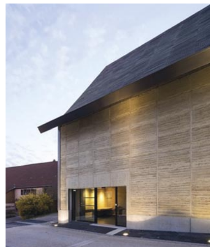
Figure 11 : Un complément construit en terre
