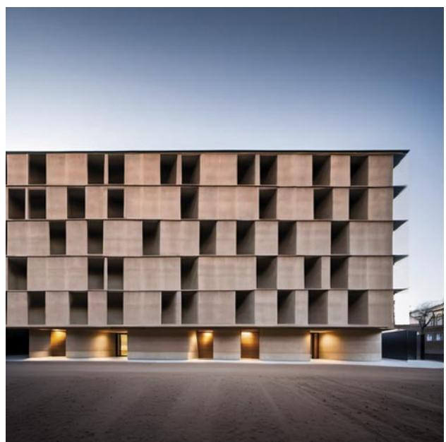
Une architecture habitative aux formes simples réalisée en pisé préfabriqué, protégée par des rebords de toiture qui servent à éloigner la pluie. La structure existante d'une résidence est renouvelée par un système de panneaux préfabriqués en terre crue.
