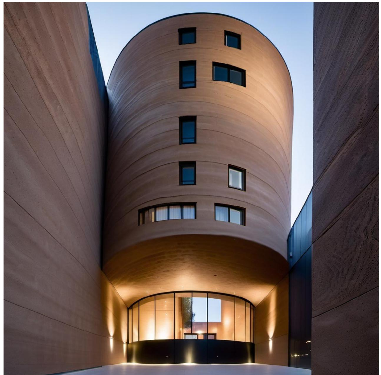
Un programme mixte d'architecture mêlant bureaux et logements, imprimé en terre 3D. Les murs courbes sont rendus possibles grâce à la liberté de mouvement des bras robotiques sur lesquels sont montés les embouts.
