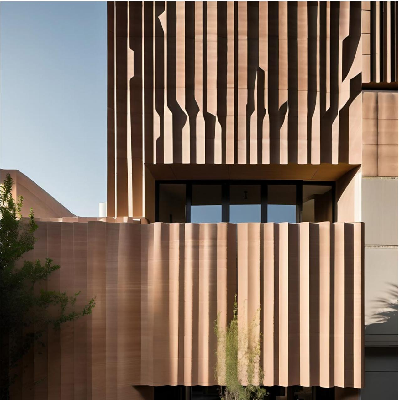
Une architecture où les éléments verticaux sont soigneusement façonnés pour créer des zones d'ombre sur la façade, améliorant ainsi l'isolation thermique du bâtiment et favorisant une régulation plus efficace de la température intérieure. Des panneaux structuraux en pisé préfabriqués sont compressés et installés sur site pour optimiser la construction.
